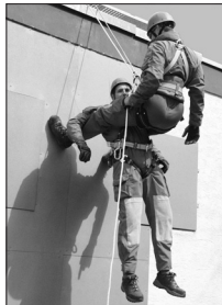
Esempio: Evacuazione tramite l'utilizzo del dispositivo di discesa Milan.
